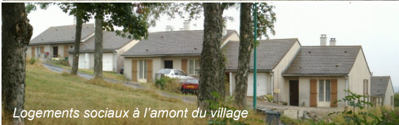
Pavillons à l'amont du village
